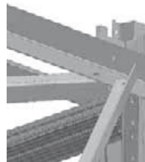
Attacco controvento orizzontale Horizontal bracing connection
